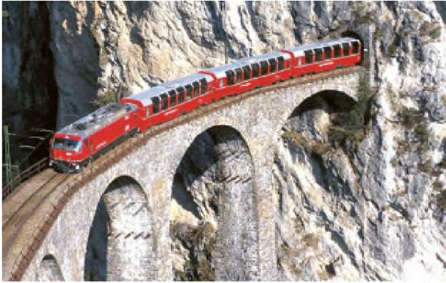
احداث تونل و پل برای عبور قطار در ناحیه‌ای کوهستانی و برف‌گیر - سوئیس
